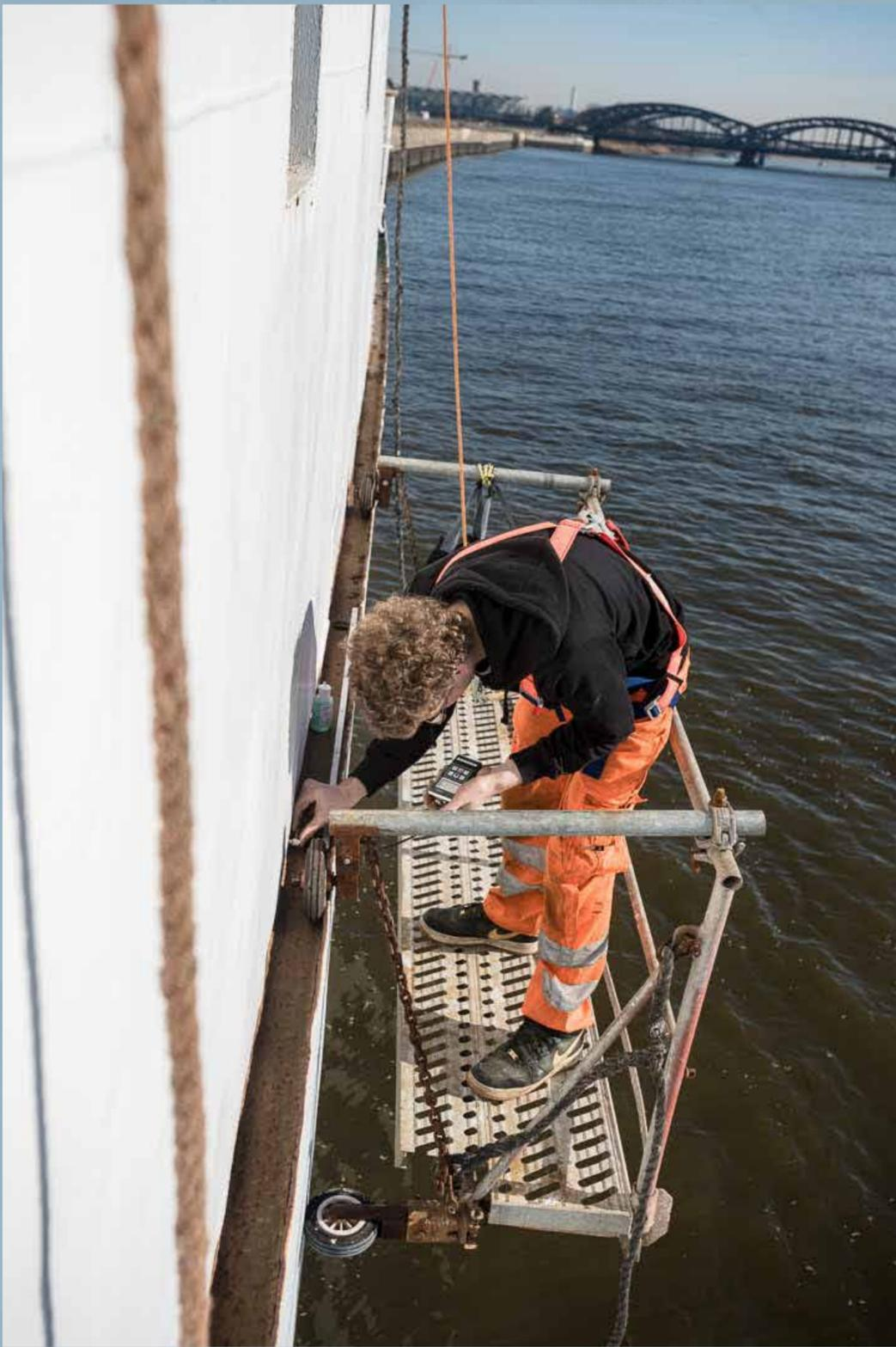
Eine weitere Großbaustelle des letzten Jahres befindet sich an den Seiten des Schiffsaufbaus, über dem Scheergraben. Dieser Wassergraben war über eine Länge von 50m stark korrodiert und musste stahlbaulich ersetzt werden.
